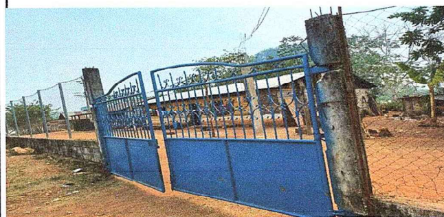
Foto 3: Aquí se finalizo el mantenimiento del porton.
