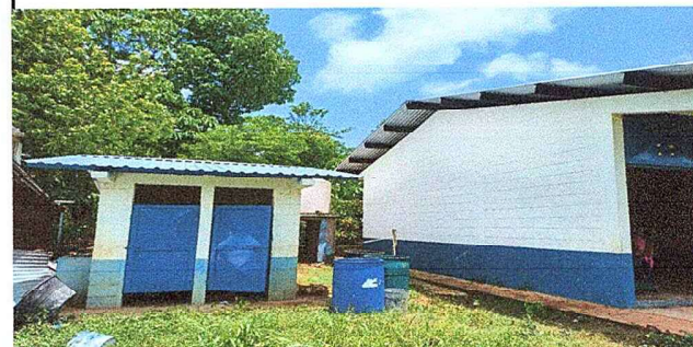
Foto 4: Aquí se finalizo el mantenimiento de la letrina.
